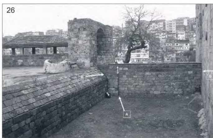
A Témoin de la pile nord du pont-levis. B Niveau de pose du pont-levis. C Traces d'arrachage.
